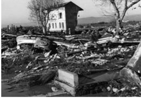
Figure 2 : Dégâts causés par la rupture du barrage 70
