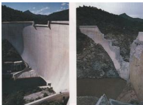
Figure 1 : Le barrage de Malpasset avant et après l'accident 69
