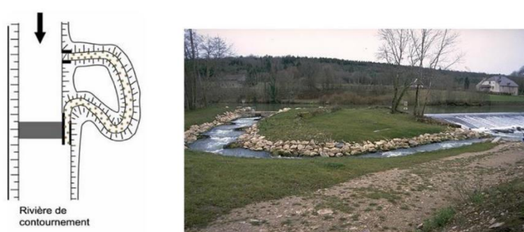
Figure 9 : Passe à poissons dont le dispositif requière de créer une extension de la rivière afin de contourner le barrage. 54
